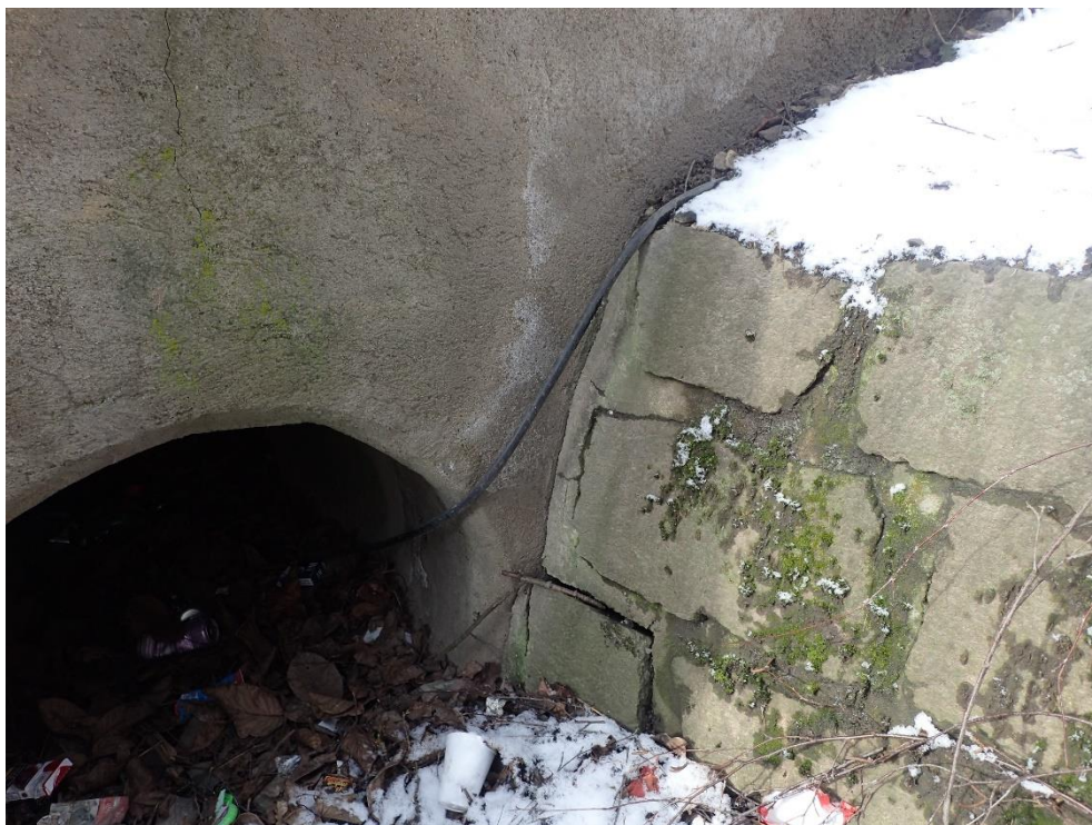
Foto 5: Uvnitř propustku nezjištěný kabel
