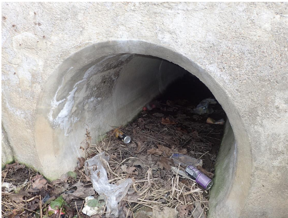
Foto 3: Výluhy a praskliny na čele; propustek částečně zanesen
