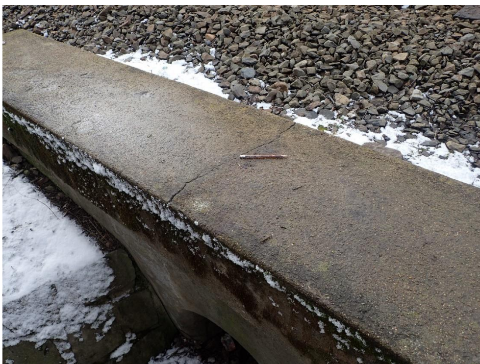
Foto 4: Prasklina na pravé čelní římse propustku
